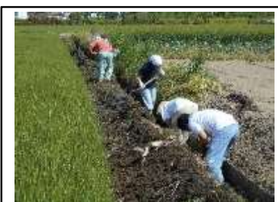
( 水路の泥上げ )
