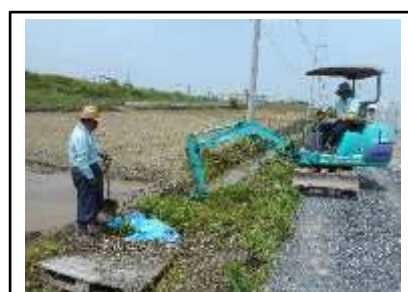
( 水路の泥上げ )
